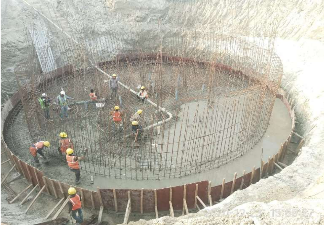
ICI Nalla IPS Raft casting
