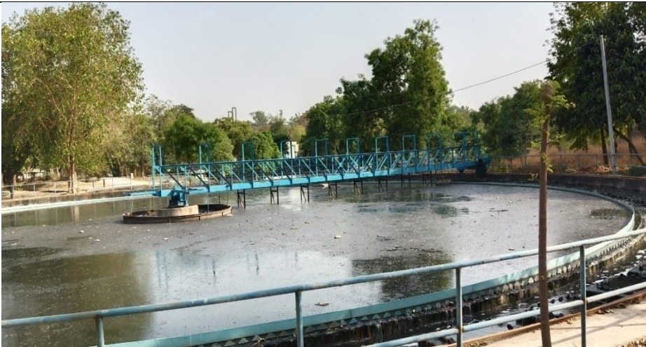
130 MLD Jajmau STP
