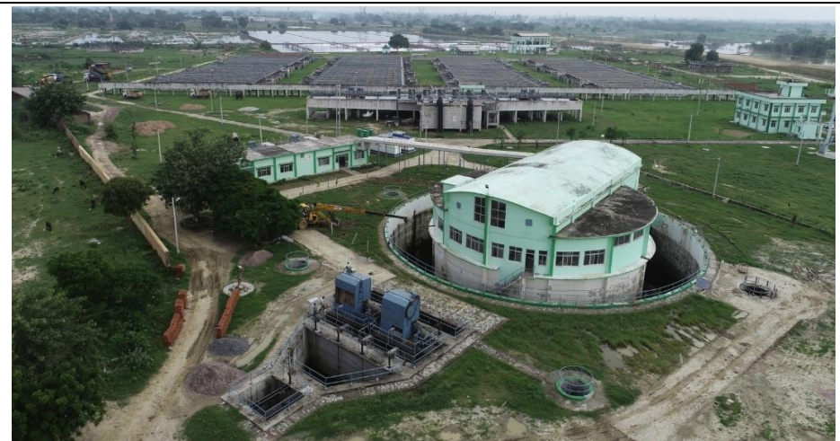
Bingawan 210 MLD UASB STP
