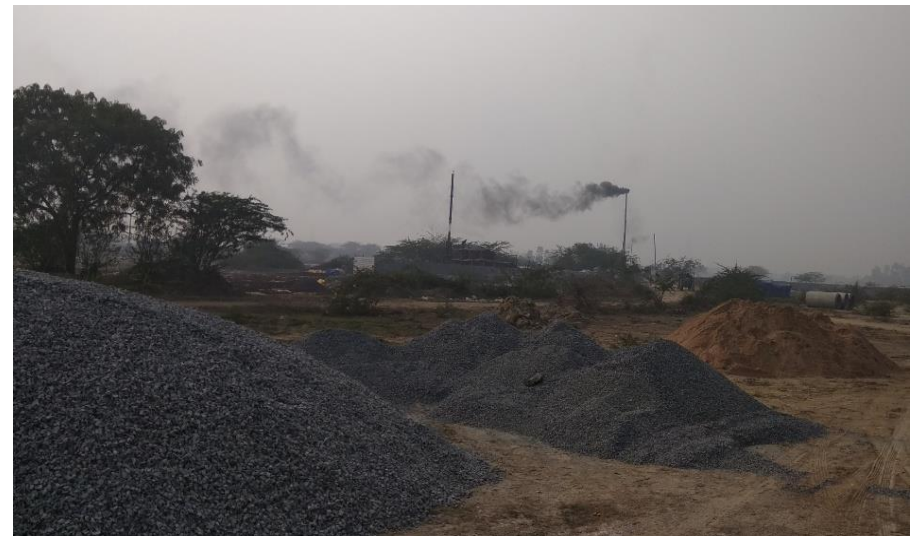
Unnao STP Site
