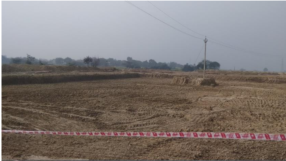
Pankha STP Site
