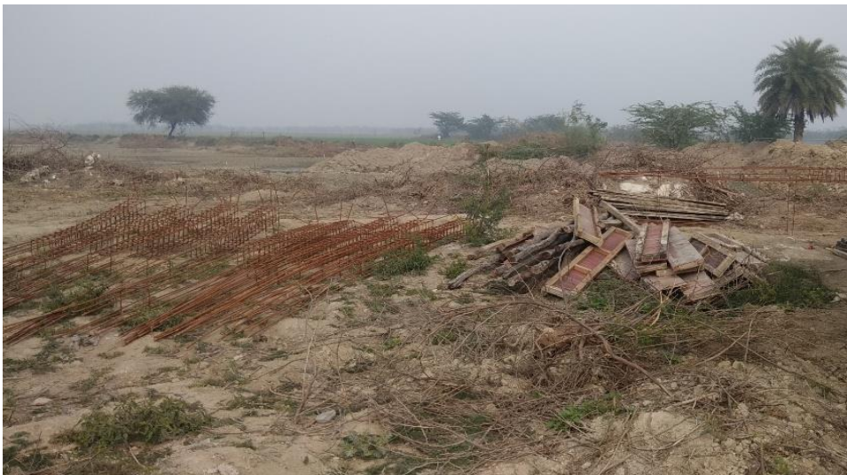
Unnao STP Site
