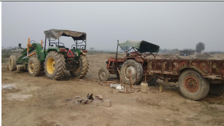
Unnao STP Site
