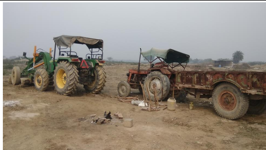
Unnao STP Site
