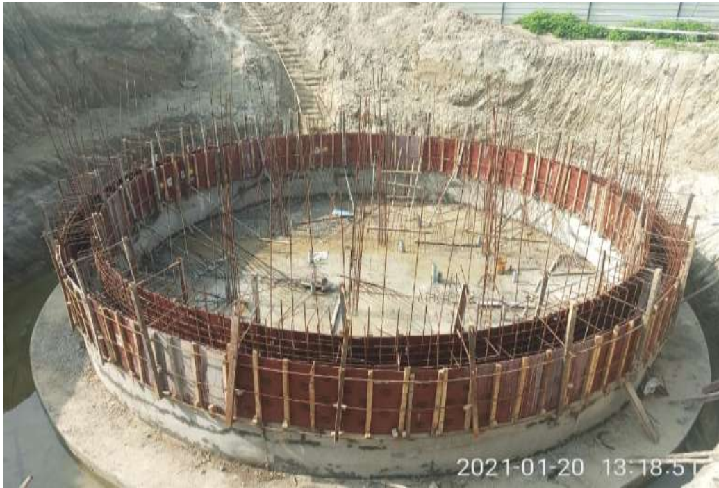
ICI nala IPS shuttering
